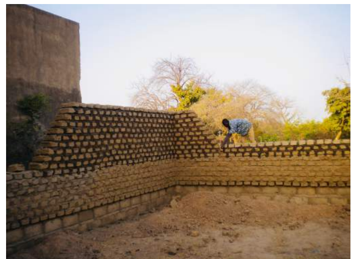
Construction de l'étable en banco
