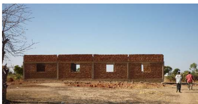
Les premiers murs se dressent
